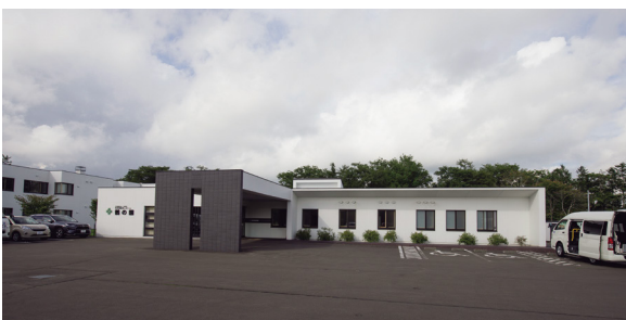
敷地面積2万4869㎡の敷地に立っている建物面積4929.75㎡の建物は、鉄筋コンクリート造りの平屋と2階建てが連結されている
